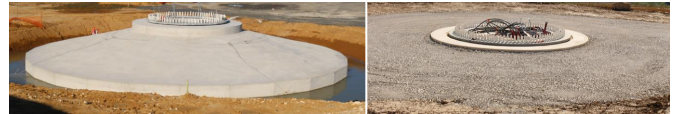
Fondation d'éolienne avant et après recouvrement (Source : Ora environnement)
