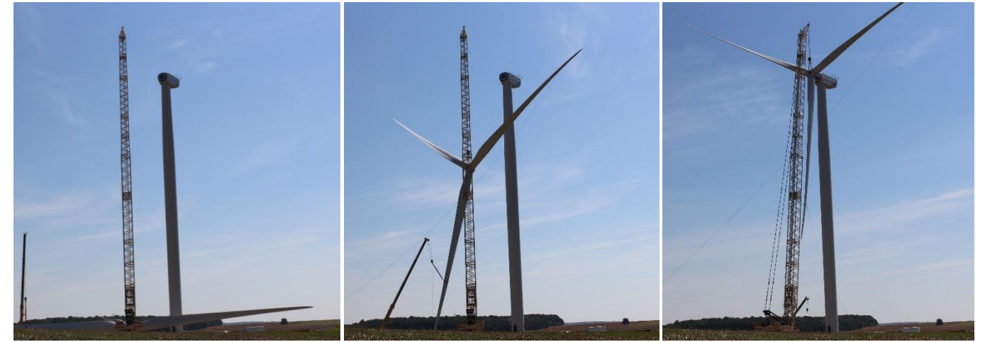
Étapes du montage du rotor d'éolienne (Source : Ora environnement)
