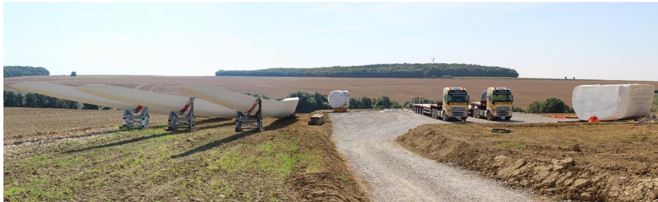
Éléments d'éoliennes avant montage (Source : Ora environnement)
