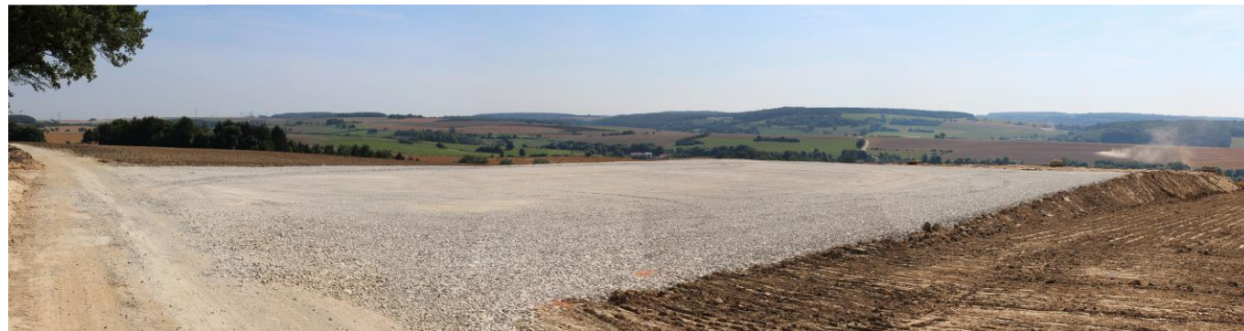
Plateforme de montage d'éolienne (Source : Ora environnement)
